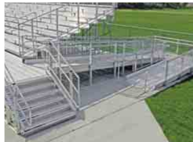
ADA Accessible Ramp
